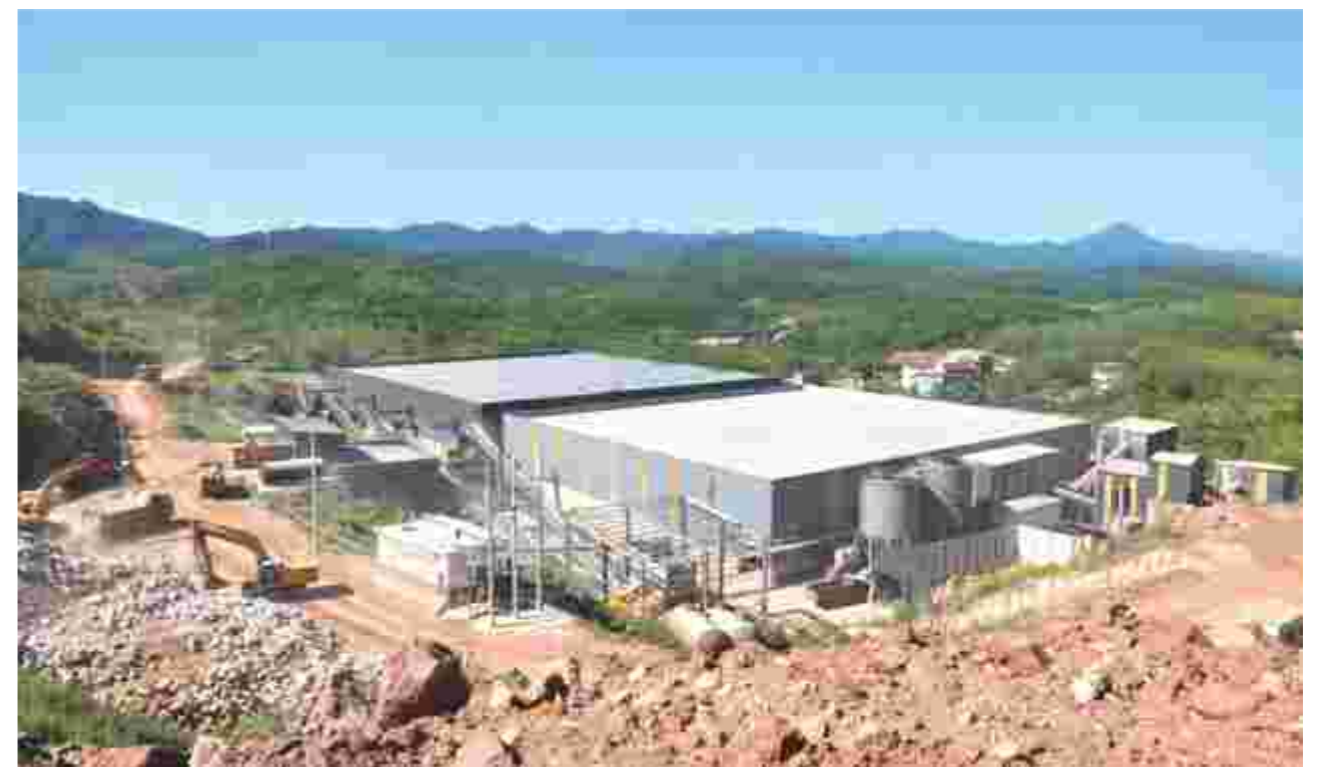
江西时产1000~1200吨石灰石破碎全骨料水洗生产线
